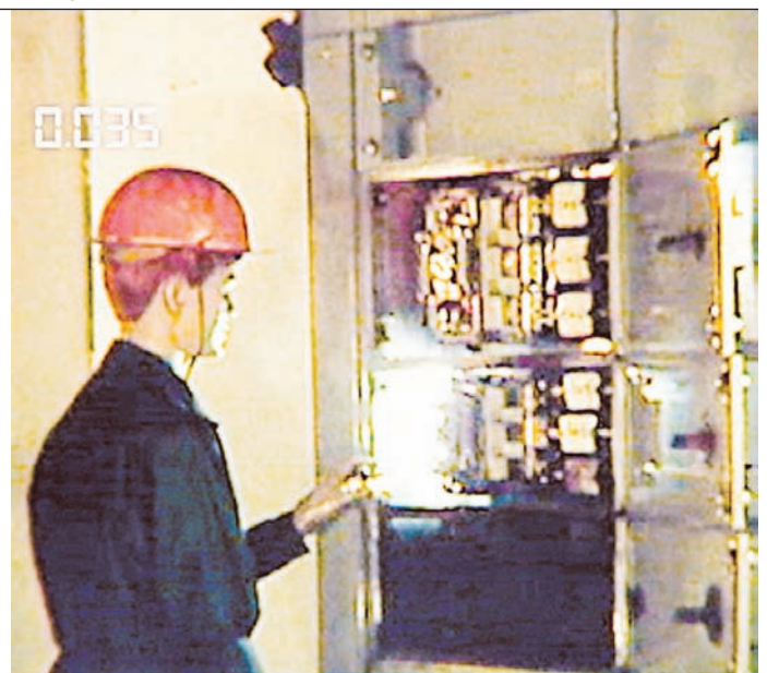
1b Acidente por arco com o Sistema de Protecção de Arco™ da ABB
